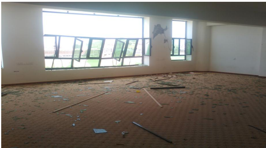
صور من الداخل لمبنى الوزارة الجديد- صنعاء
